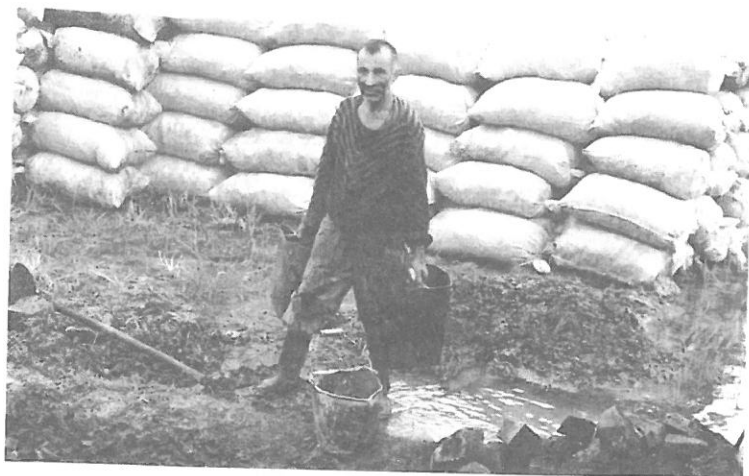
تصویر شماره‌ی (۱۳) گودال آب در کنار پاچال
